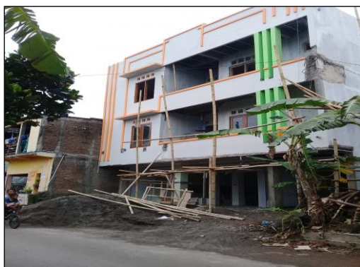
Gambar 2. Fasad Bangunan Kost Putri sisi Timur
