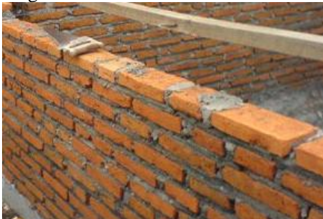
Gambar 3. Pemasangan Dinding Bata Merah
