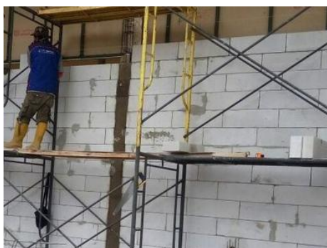
Gambar 4. Pemasangan Dinding Bata Ringan
